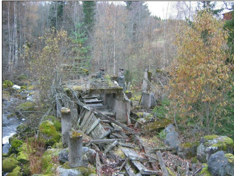
Jyränkosken myllyn ja sahan rakenteita (2009).
