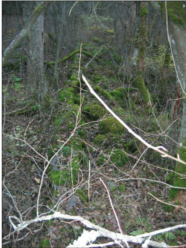
Myllyalueen kivirakenteita joilla uomaa tukittu
