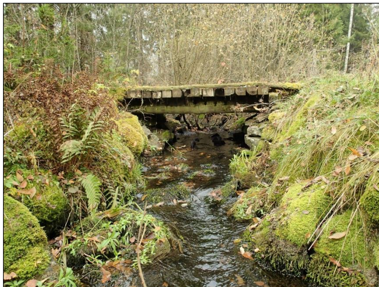
Perattua puron uomaa sekä puusilta kiviperustuksineen (2015).
