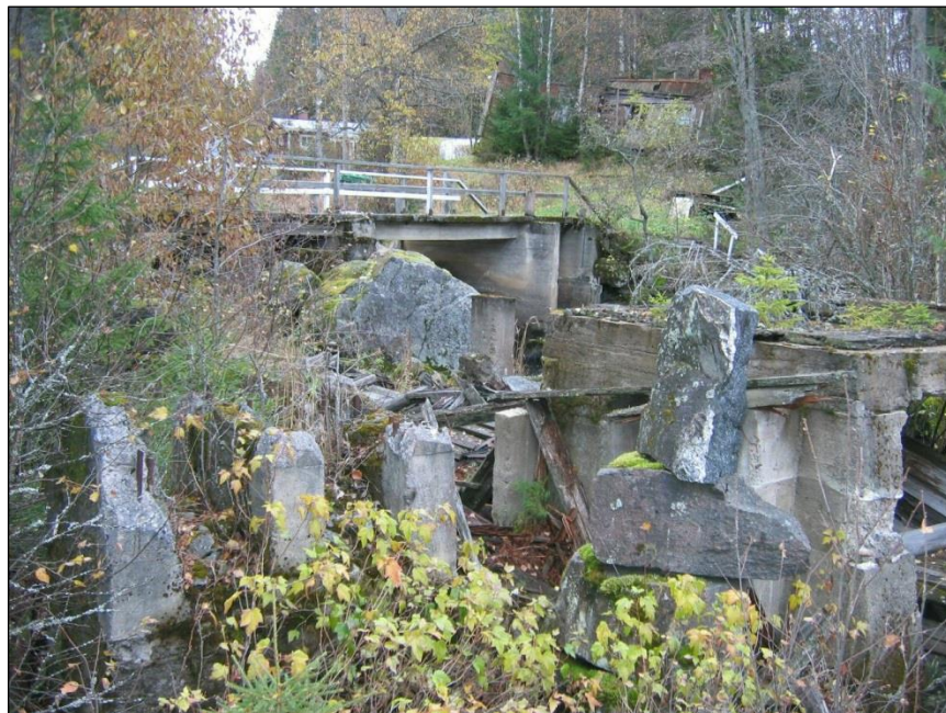
Jyränkosken myllyn ja sahan rakenteita. Betonista tehty maantiesilta joka samalla toimii patona (2009)
