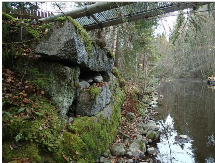
Vanhaa siltakiveystä jokirannassa. Kuva lounaaseen (2015)
